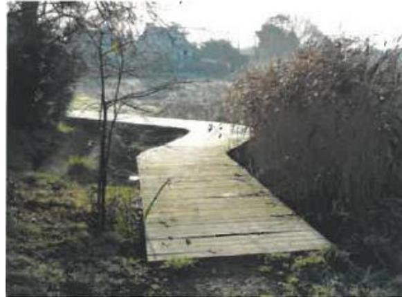
Figure 8 : Exemple de platelage
