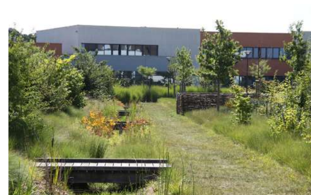
Exemple de noue de gestion alternative des eaux pluviales
