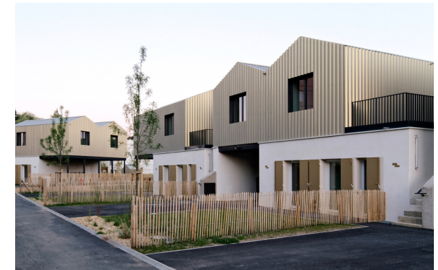
Guillaume r millien (sarl d'architecture) "L'Eco-cité la Garenne"
