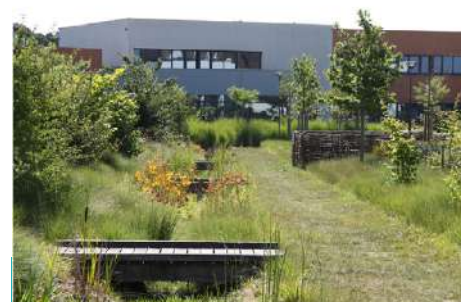
Exemples noue eaux pluviales
