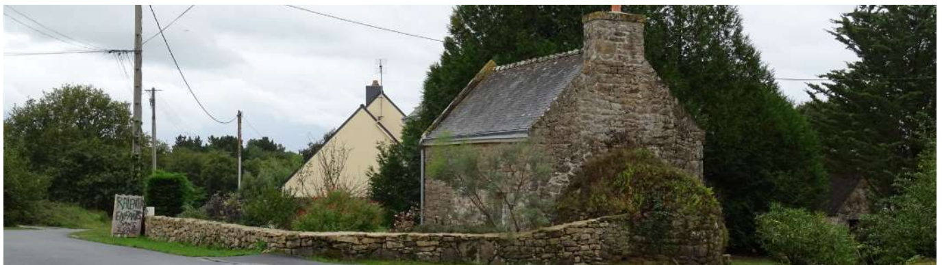
Dans les hameaux le bâti traditionnel côtoie le bâti pavillonnaire moderne qui contraste par sa teinte et son implantation en retrait de la voie.
