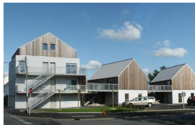
TRIGNAC «11 LOGEMENTS SEMI- COLLECTIFS » 2006
