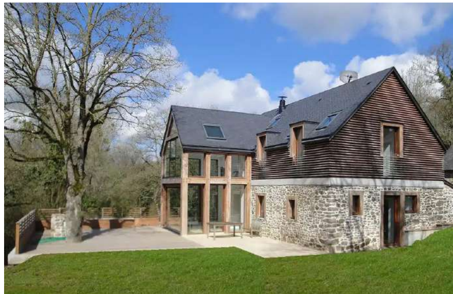
▲ PLOREC Rénovation Colas Durand
