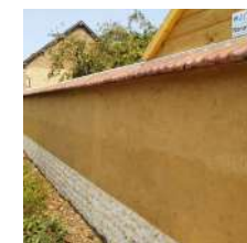
Bauge enduite terre
