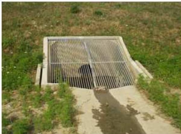
**Grille de protection sur ouvrage de sortie**
