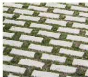
Pavage en béton avec ouvertures de drainage
