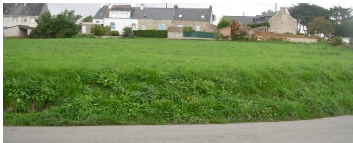
Vue du secteur Nord (A)
