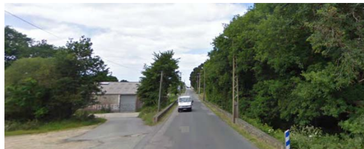
Vue n°1 vers Pont Lorois au niveau de Kernio
